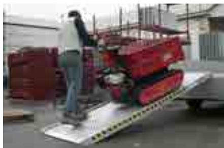
BAUWERBE UND STRASSENARBEITEN
