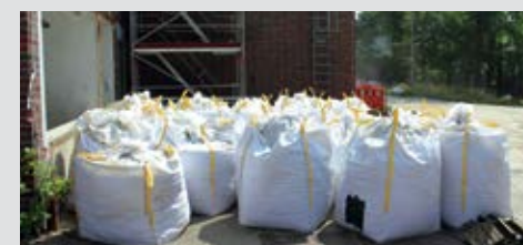
KMF-Material, verdichtet und abgefüllt in Big-Bags direkt vor einem Abriss-Objekt
