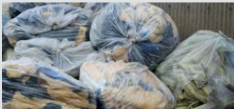
Materiale in MMMF in sacchi di PE
